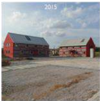
2015 Shandong Dazeshan Hostel 山東 大澤山客棧
